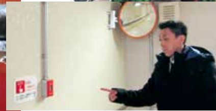
◀西府駅地下道安全点検
