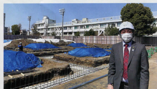
一中仮設校舎建設状況
